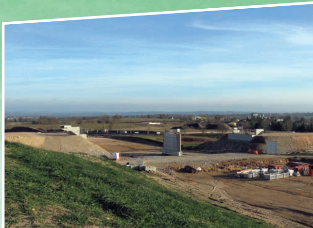
Le futur échangeur des Molinières en construction
