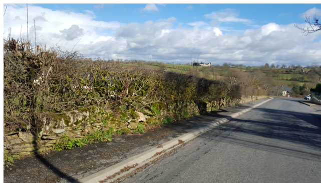
Muret bordant la parcelle 1
